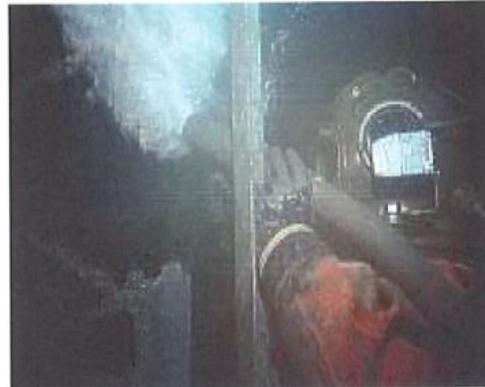
Taucher beim Sandstrahlen nach Hochdruckreinigung
